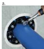
b. Serrare i tiranti ruotando in senso orario non più di 4-5 giri alla volta. Ripetere l'operazione fino a quando non è raggiunta la coppia indicata in tabella e la gomma sorge dalle piastre di serraggio in modo uniforme.
