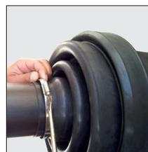
4. Infilare la guaina sul tubo condotta e infine fissare ai tubi con le reggette in dotazione.
